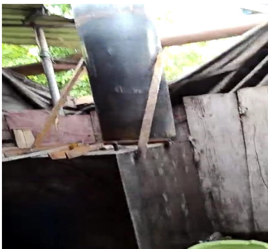
项目排气筒现状情况
