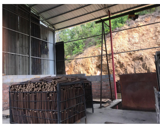
项目厂区现状情况
